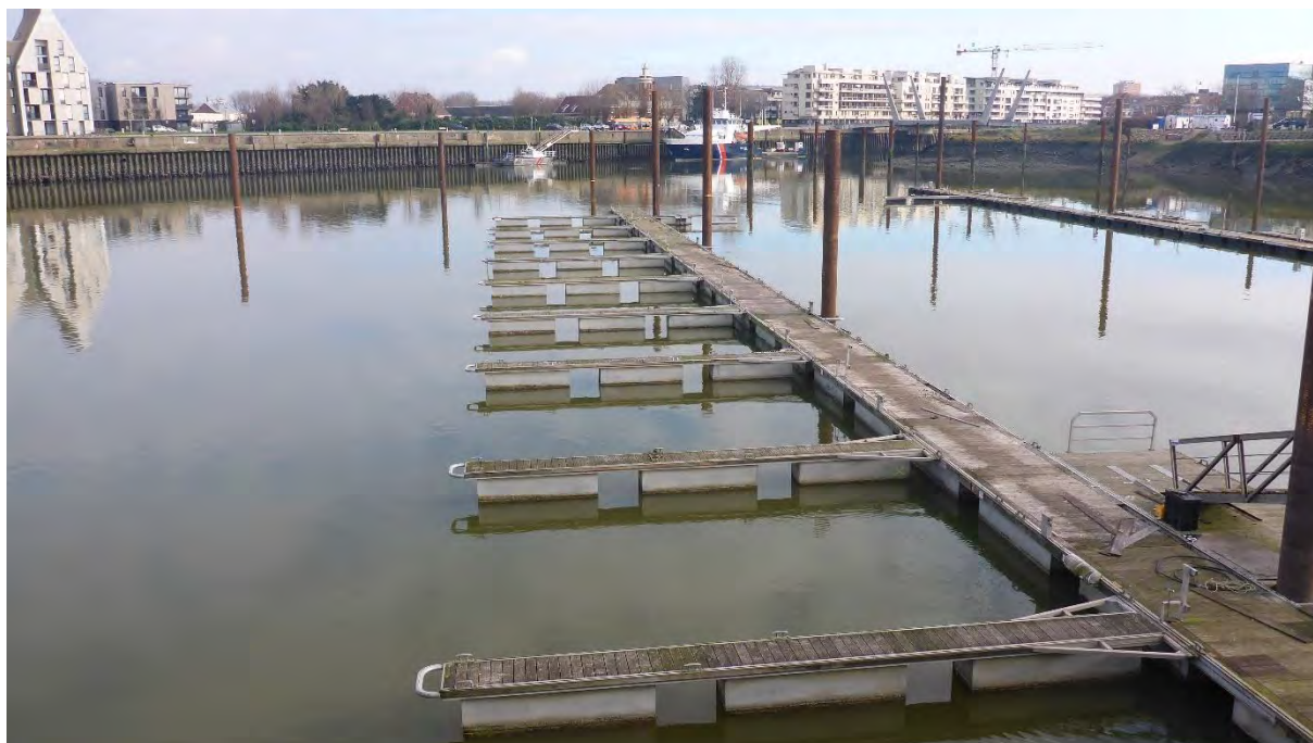
Le 3/02 : ponton et catways sur un flanc, pour permettre à la barge de battre les pieux, encore de hauteur différente.
